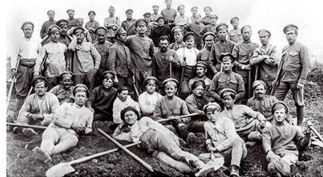
Русская рабочая рота 3/2 на строительстве дороги
